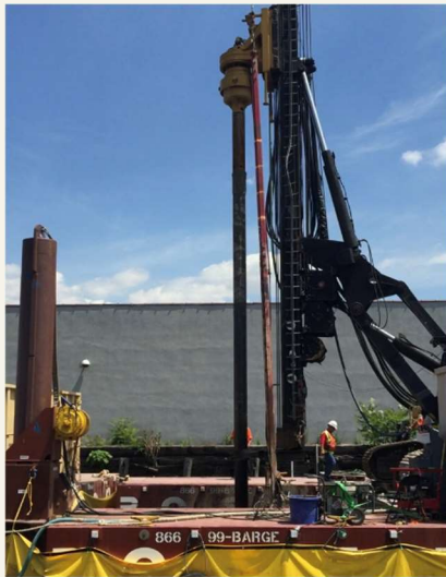
Barrena mezclando cemento con el sedimento nativo contaminado durante la ISS piloto en la dársena de maniobras de 7 th Street (realizado en
