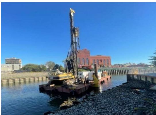
Equipos de perforación de estabilización in situ localizados entre 3 rd Street y Carroll Street
